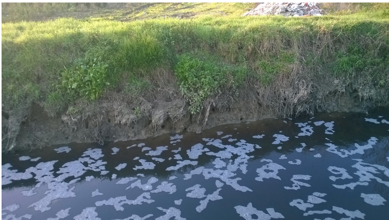
Figura 2 piede arginatura destra Calicino a monte Via Casale e Faticci con evidenti fenomeni erosivi.
